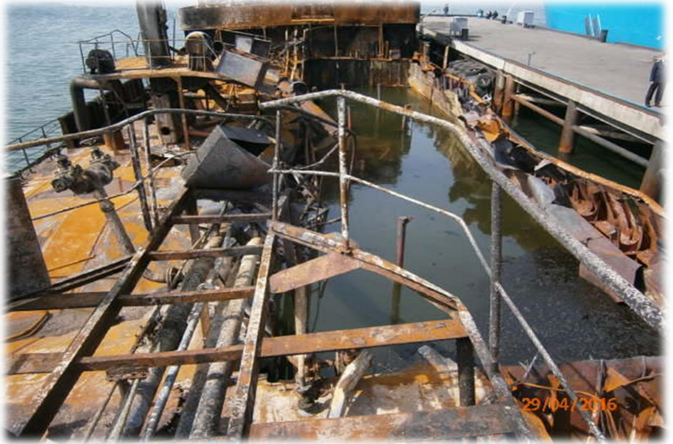
Şəkil 17. Üst göyertənin dağılmış hissəsinin burun hissəsindən ümumi görüntüsü
