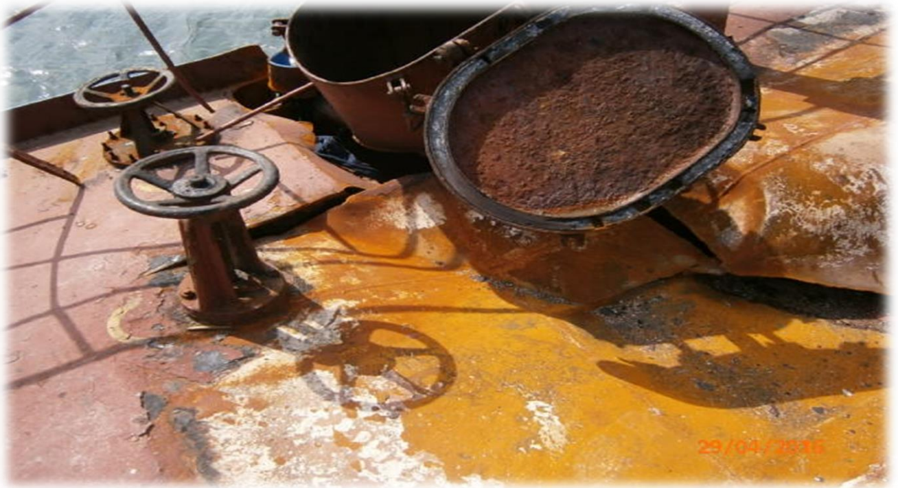
Şəkil 21. Tankın giriş qapağı
